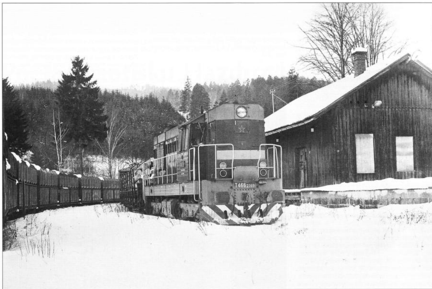
Po zkouškách „elektronika“ T 466.2369 na ozubnicové trati z Tanvaldu do Harrachova sériové lokomotivy řady 743 umožnily díky regulaci výkonu a elektrodynamicke brzdy přejít na adhezní provoz a zjednodušit a zlevnit dopravu.
