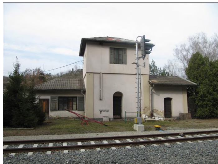
Obrázek 4: Objekt vodárny na pozemku st.p.č. 30.
