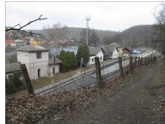
Obrázek 1: Pohled na žst. Davle přes přístupovou komunikaci k domu č.p. 14. V pozadí Starý davelský most.
